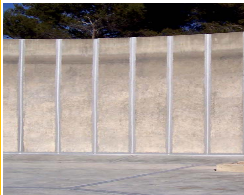
Detail těsnění namáhaného tlakem z negativní strany:
