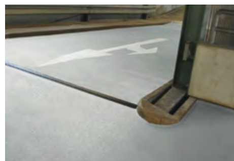
Podlahové spáry a detailní řešení, strana 26
